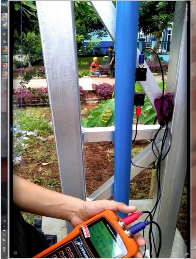
Pengujian konstruksi mixer dengan Flow Meter
